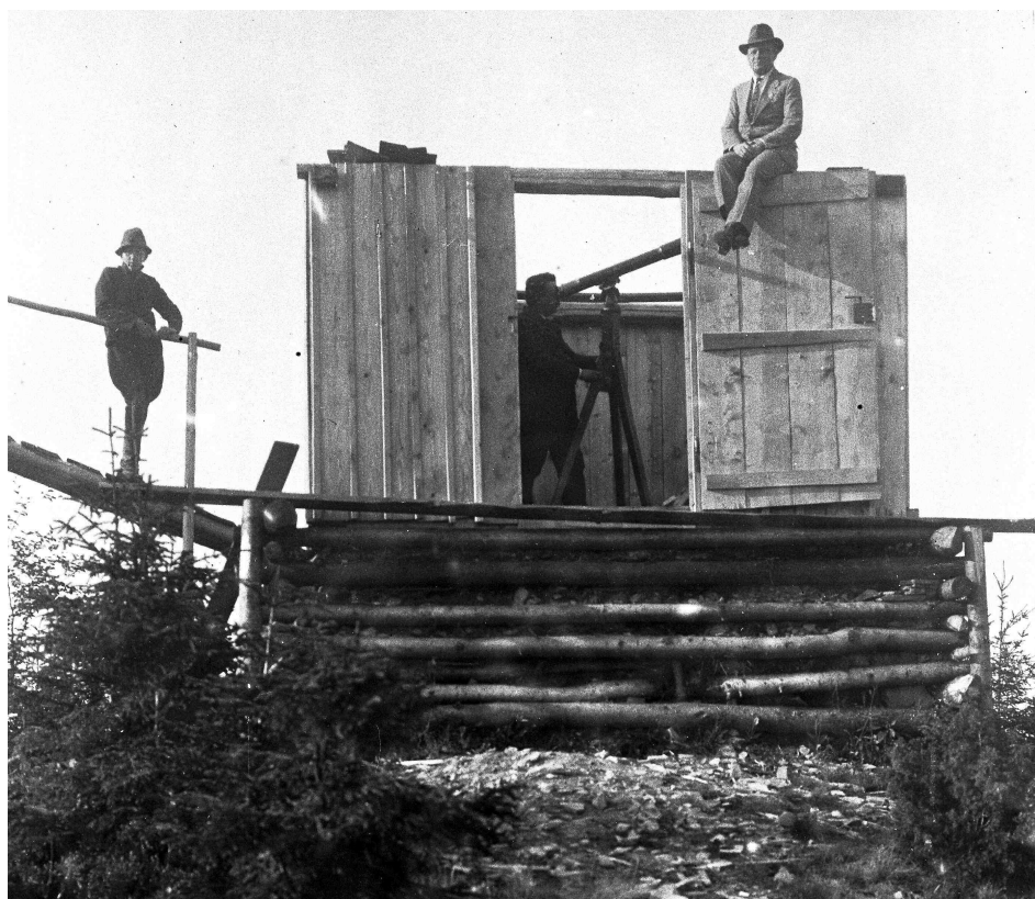
Pawilon lunet w trakcie budowy.
