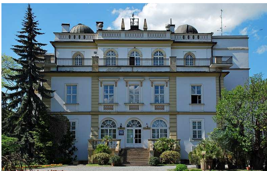
Obserwatorium UJ. Na pierwszym piętrze widoczne okna dawnych mieszkań Banachiewiczów i Kordylewskich.
