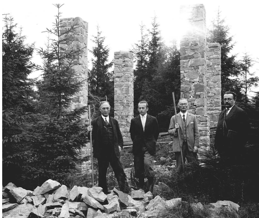
Nieukończona budowa wysokiego pawilonu (ok. 1935 r.). Od prawej: T. Banachiewicz i Antoni Wilk.
