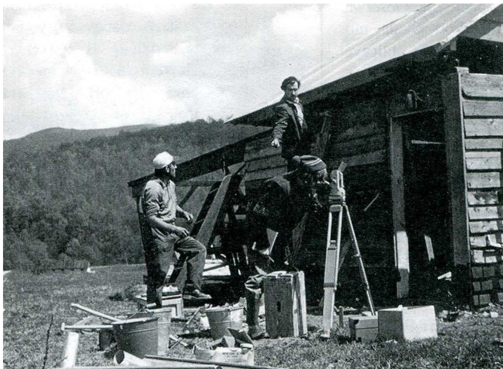
Budowa pawilonu stacji obserwacyjnej w Roztokach Górnych ok. 1970 r. (fot. A. Michalec)
