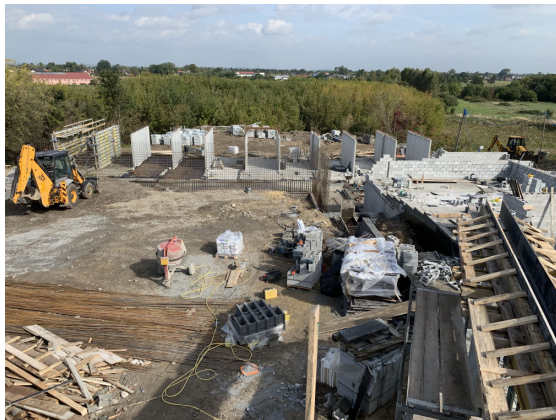
Postęp prac budowlanych.
