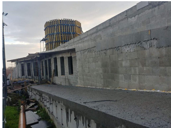
Zalążki nowego budynku.
