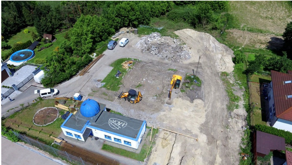
Przygotowany plac budowy.
